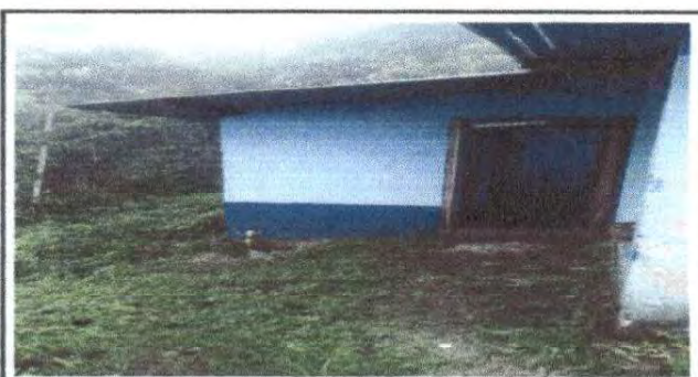
Foto 17: Mantenimiento de lámina (Sanitarios)
