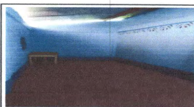
Foto 6: Sustrucción de paredes de lamina por block en (modulo de direccin)
