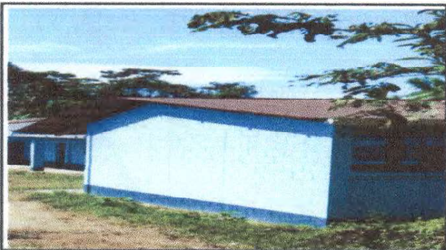
Foto 7: Mantenimiento de lamina (cepillado y pintado) (modulos de aulas)
