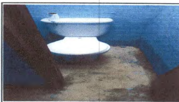
Foto 10: Sustitución de inodoro
