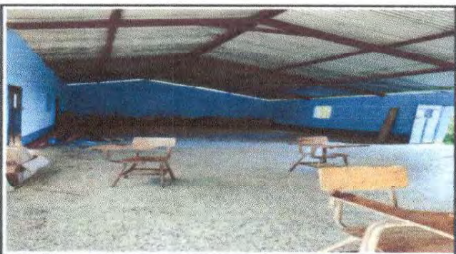
Foto 9: Repello en muros interiores (modulos de aulas)
