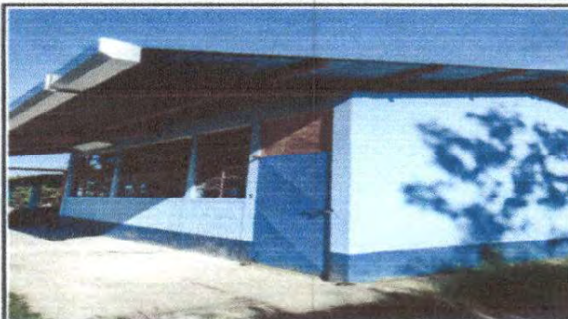
Foto 14: Sustrucción de canal de metal
