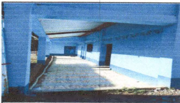
Foto 8: Repello en muros exteriores (modulos de aulas)
