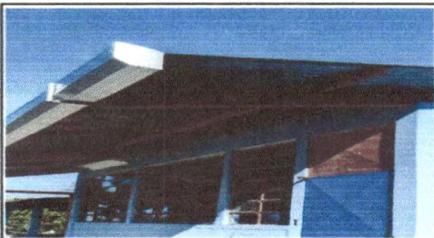
Foto 15: Sustrucción de Vidrios
