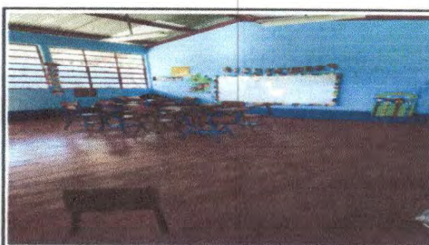
Foto 12: Pintura en muros interiores (modulos de aulas)
